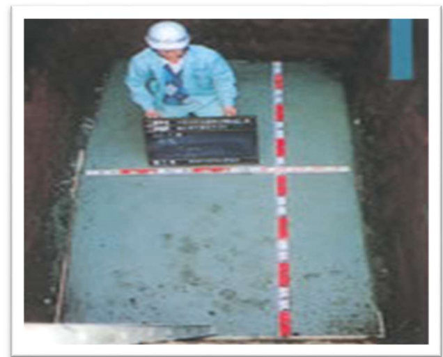
写真5 基礎工事の状況を示す写真（基礎底板コンクリート）（2枚～数枚程度）
