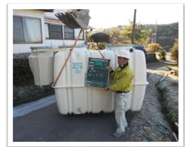
写真6 浄化槽本体及び浄化槽搬入状況を示す写真（2枚～数枚程度）
