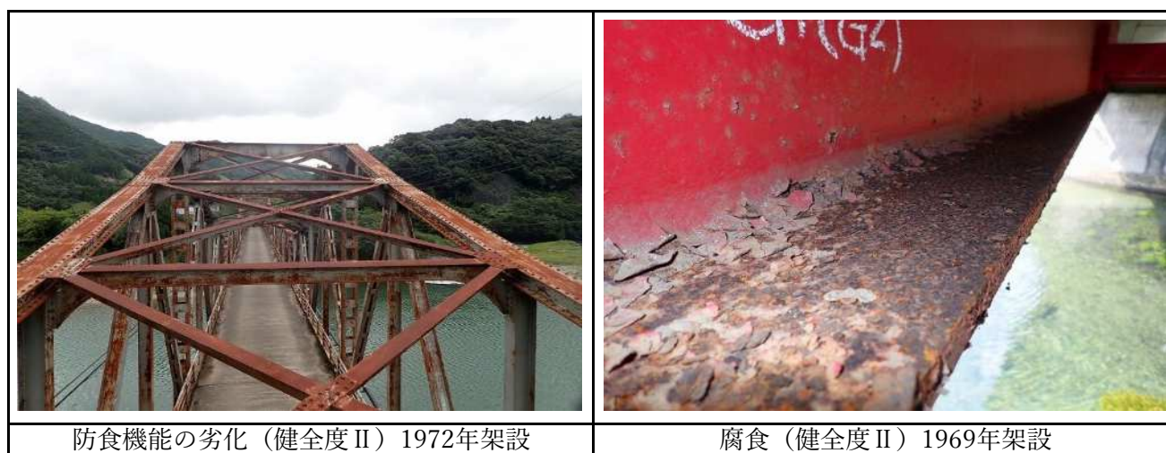
図 6 損傷状況
