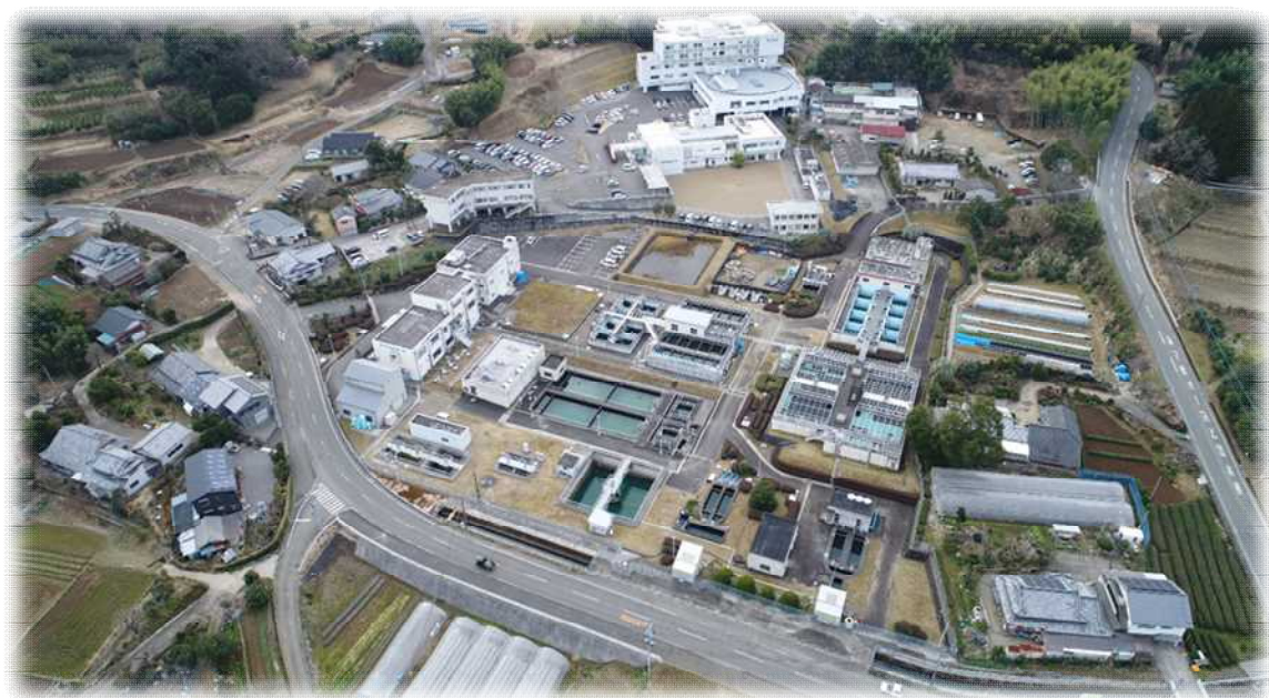
日向市権現原浄水場施設全景
