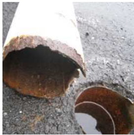
ポール看板の倒壊
