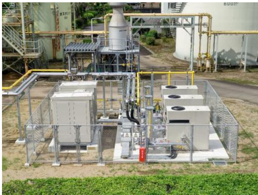
図4 日向市浄化センターにおける消化ガス発電設備
