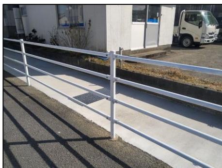
防護柵による歩車分離
