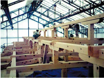
□小屋組：桁方向の斜材は元々なかったもの
