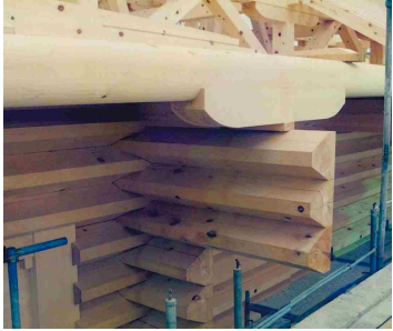
□校木の持ち出し部の上に軒部の丸桁を据えつける
