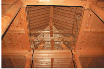
西の正倉院：吹抜から小屋裏の和小屋組が見える。斜めにあるのは軒の隅出梁を受ける枯木（はねぎ）である。柱にエンタシス（ふくらみ）を施しているのがわかる。
