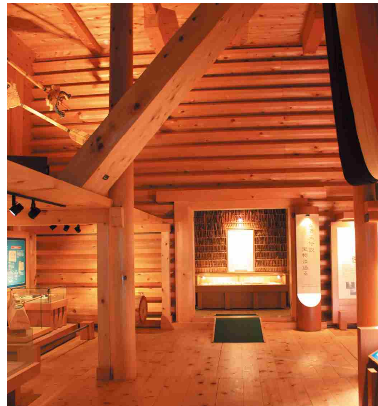
□中倉内部：北倉校木の上部に梁がかかり途中でとまっているのがわかる
