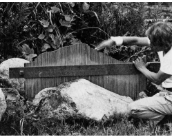
□石口をトレースする道具、オサ：たくさんの竹を細く裂いて、2 枚の板で挟み込んだ定規で石の表面をトレースする。（よみがえる「薬師寺西塔」より転写）
