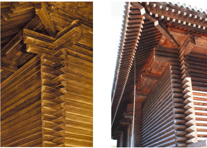
□出隅部の校木：左：奈良正倉院、右：西の正倉院 左は明らかに校木の出の寸法調整をしているが右ではそれほど多く感じられない。また、左は大正の修理の約 50 年後の写真であるが軒の隅木のたわみが出ている。
