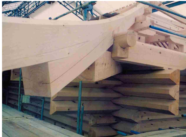
□隅木を下から見るとシステムがわかる
