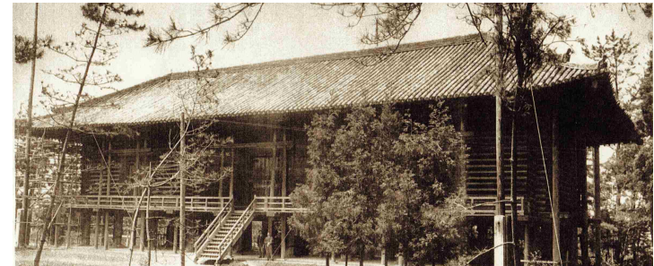
□大正2年の大修理前に撮影された全景：軒の支柱、恒久的な階段があるのがわかる。
