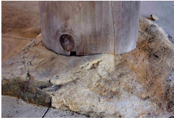
□礎石と柱脚：石の凹凸にあわせて柱脚を加工している
