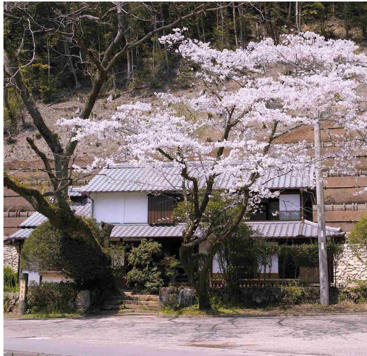
□ 牧水生家主屋全景：左がセンダンの大木、右が見事に咲く山桜、いずれも生家が創建以来のもの。写真は改修工事を終えて間もない光景である。
