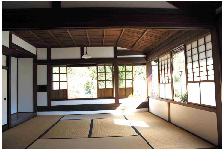
□ 2 階西のざしきを居間より見る：一階と相違して二階のざしきには竿縁天井が設けられ、格式がある。その天井は水平ではなく、小屋組みの制限を受けて三段になり、中央の天井が一番高く、床の間の天井がやや低く、南端の天井は斜めになっている。
