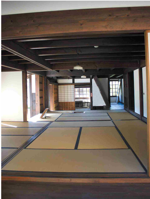
□1 階東の縁側からおもてを見る。左手が 4 帖の診察室。天井高 2050 ミリ弱、小梁下 1920 ミリ、大梁下 1750 ミリで天井の低い空間である。
