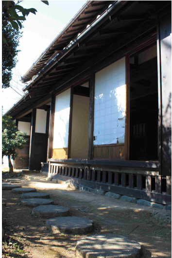
□南の庭を西のから見る。手前に診察室の障子がある。垂木と桁の間は面戸を入れず外部とつながっている。
