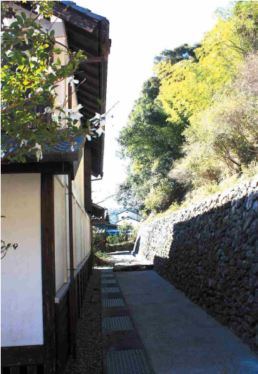
□南の庭を西のから見る。手前に診察室の障子がある。垂木と桁の間は面戸を入れず外部とつながっている。
