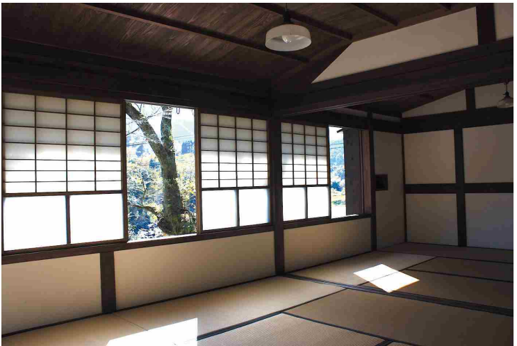
□ 2 階西のざしき：二階ざしきの天井を高くするために欄間に小屋組みの斜め梁が露出され、欄間もそれに応じて斜めになり、二階の天井の未発達ともいえる時代的な特徴を現わし、小屋組みに応じて天井や欄間の納め方に知恵が見られる。
