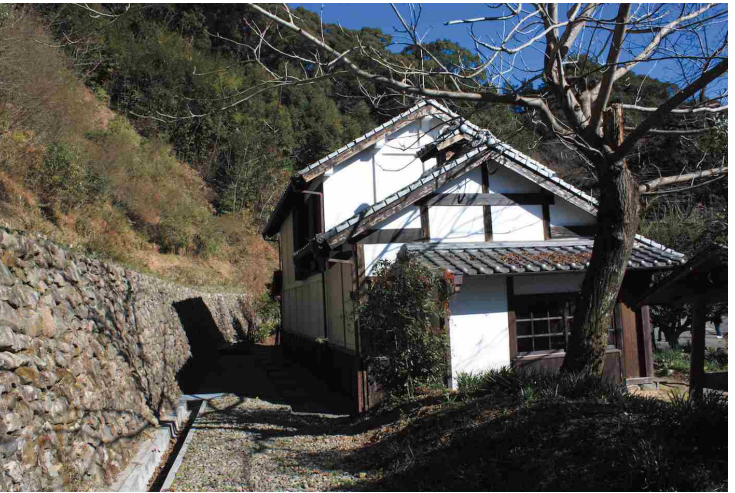
□西立面を見る。低い屋根が切妻の増築部。全体は切り妻であるが出入口は平入となっている。
