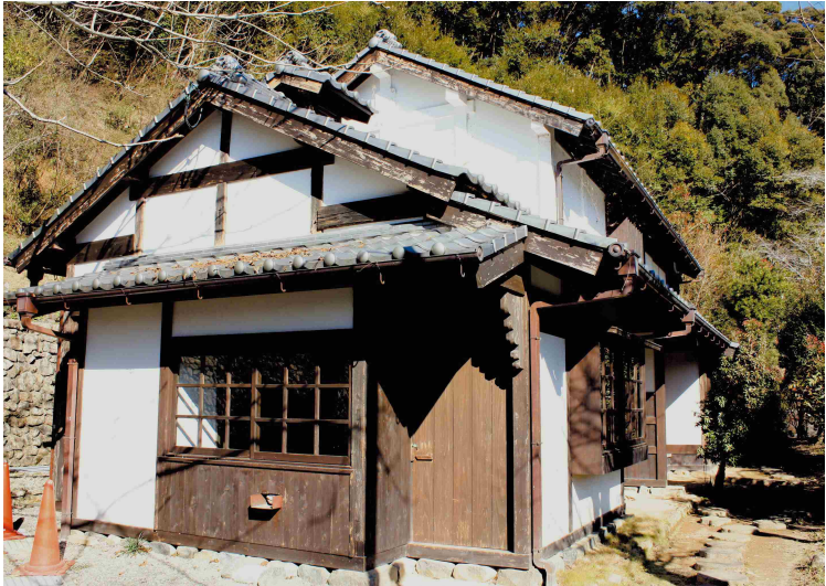
□1 階西のかまやを外から見る。切り妻の主屋に下屋の庇を廻している。かまどの煙出しの小屋根が棟の上に見える。主屋は母屋が漆喰で固められているが、増築部の妻壁は和小屋をおもてに見せいる。
