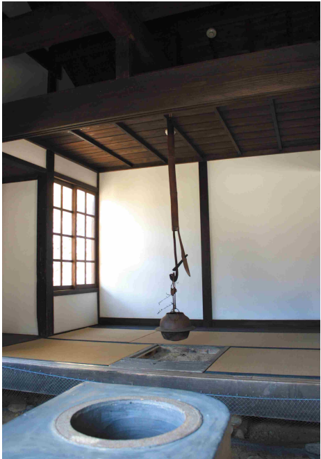
□1 階西のかまや。手前に三連の釜、いろり付き 3 畳の居間。主屋の建築の後に増築されたものである。小屋組をあらわしとしている。
