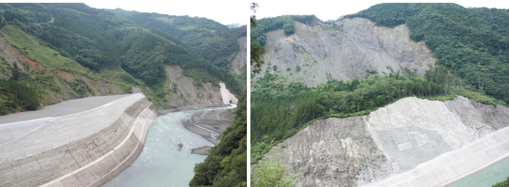
■河川改修工事完了の写真
