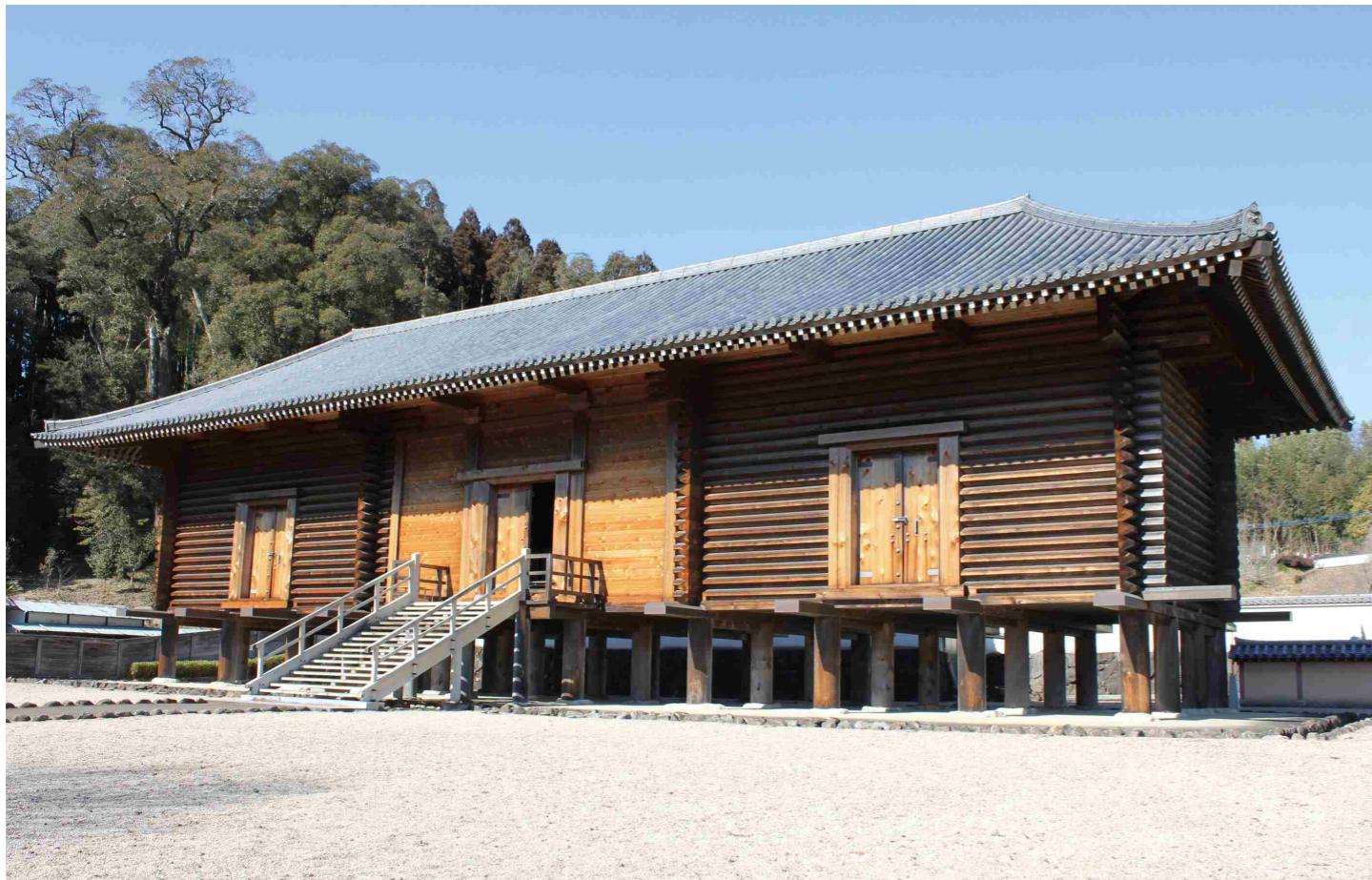
木造校倉造り高床式構造。瓦は38,000枚、原木800本が使われ、延べ9831人の宮大工によって建てされました
