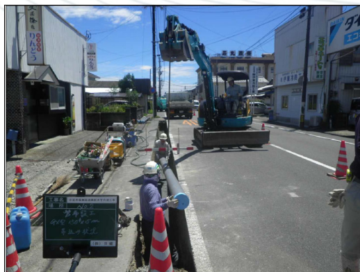
ダクタイル鉄管(耐震管)
