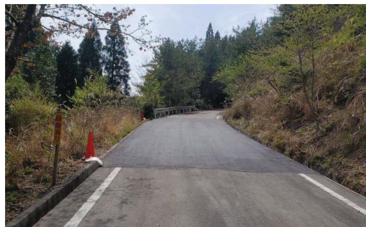
整備された林道
