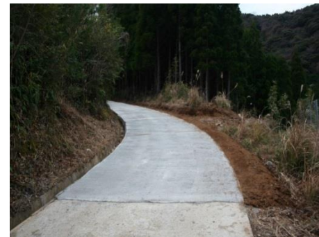
施工状況（コンクリート舗装）
