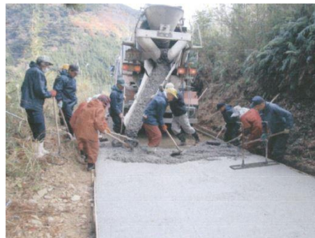
施工状況（コンクリート舗装）
