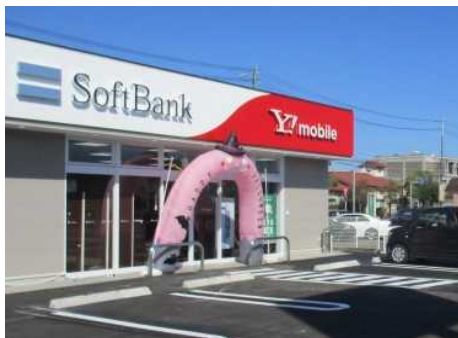
(仮称)パーソナルネット様 新築工事
