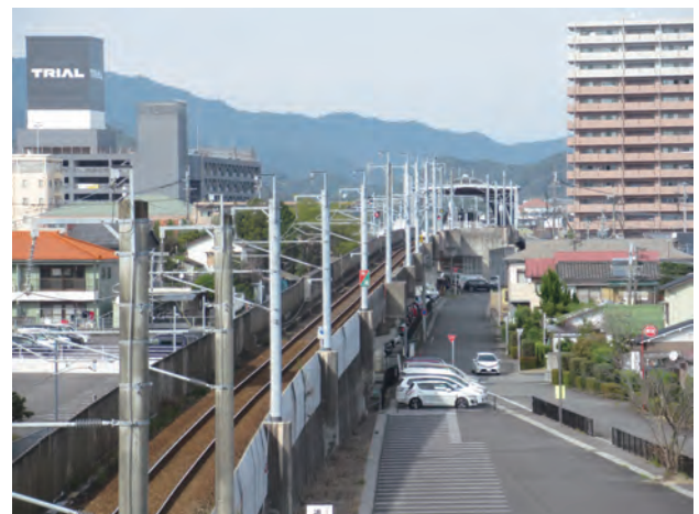
【国道 327 号から望む高架橋】
