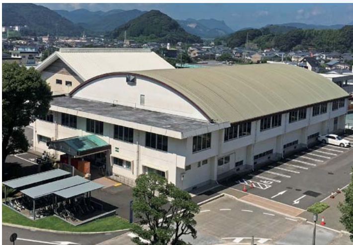
現在の市体育センター(昭和45年(1970年)建設)
