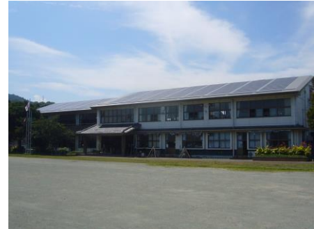
美々津小学校の太陽光発電設備
