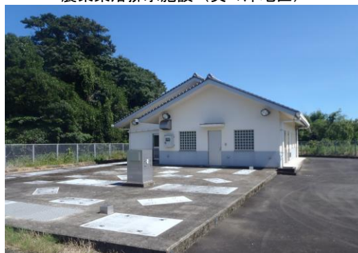
農業集落排水施設（美々津地区）
