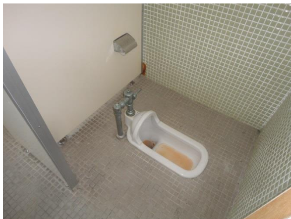
校舎 1 (2階トイレ)
