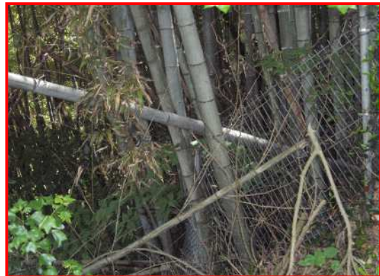
高速道路沿線より倒れこんだ竹
