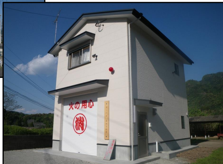
第10分団44部消防機庫
