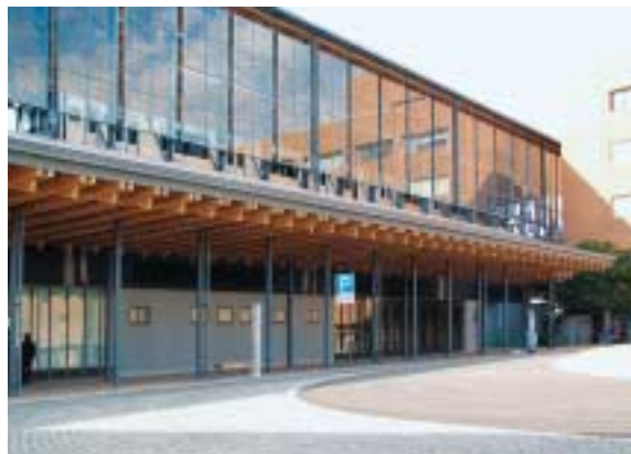
▲地元の杉を使用した庇(ひさし)
