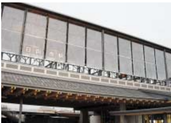
▲日向市駅駅舎
