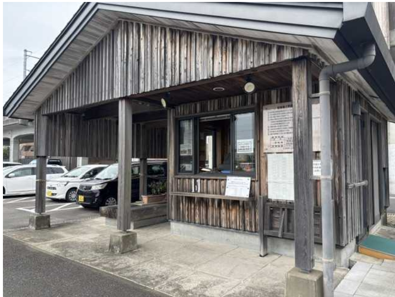
管理棟 木造平屋建て32.49㎡
