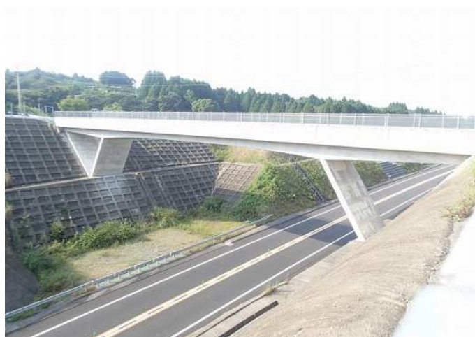
図 10 道路を跨ぐ橋梁の例（日向市管理 向ヲ原橋）
