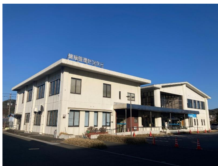
参考資料-図 18：日向市民健康管理センターの外観
