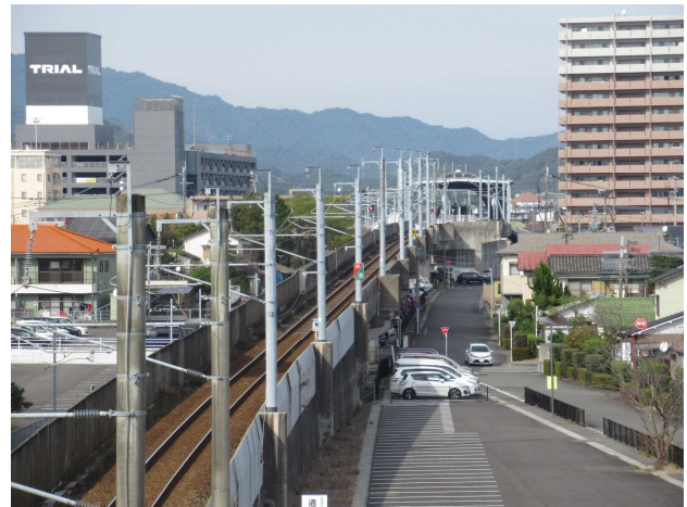
【国道 327 号から望む高架橋】
