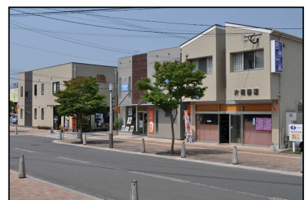
【13街区「モバイル13」】
