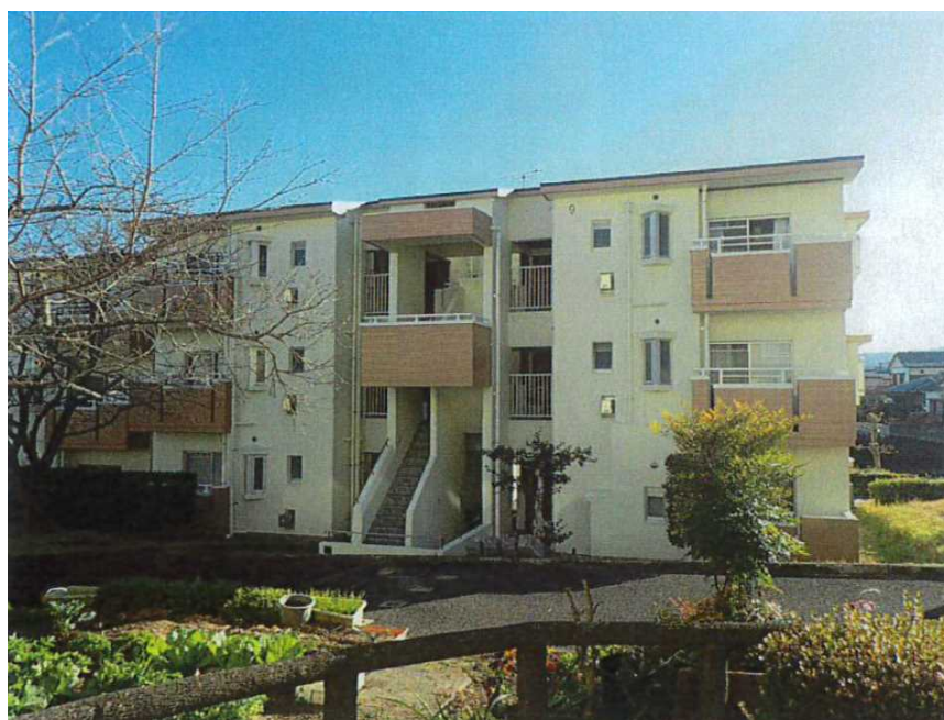
後無田住宅9号棟 改善工事完成 北面
