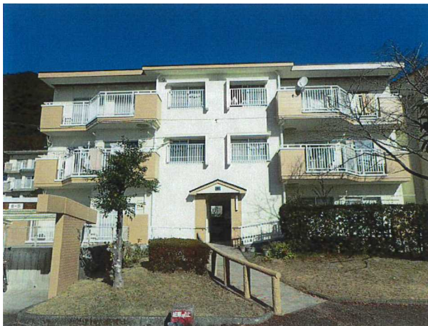
後無田住宅9号棟 改善工事完成 南面
