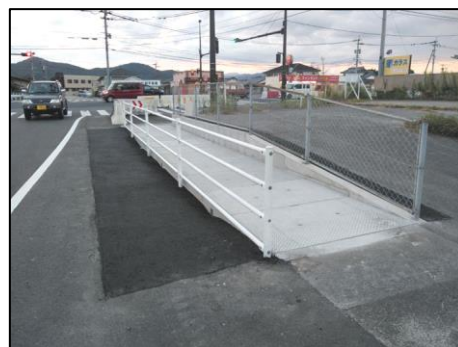
転落防護柵の設置
