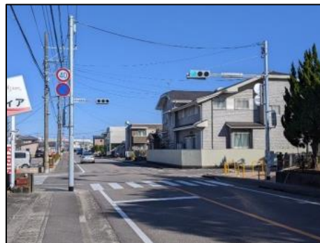
信号機の設置
