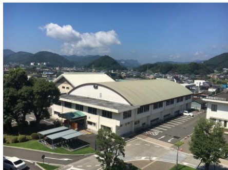
現在の市体育センター及び武道館
