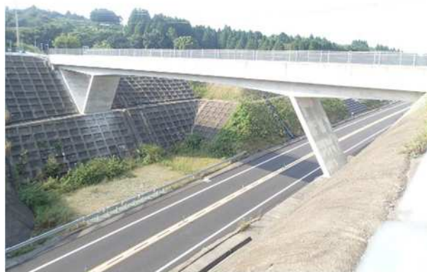
図 10 道路を跨ぐ橋梁の例（日向市管理 向ヲ原橋）
