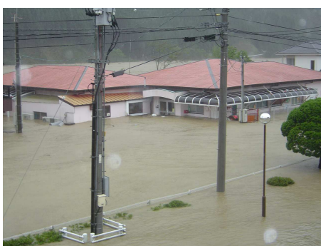
※平成17年台風14号による浸水被害
