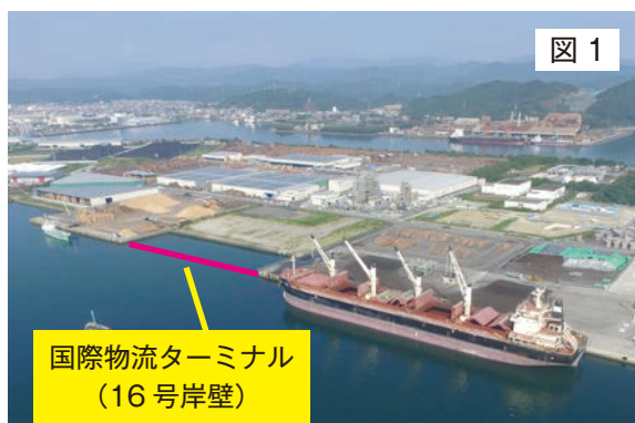
木材拠点16号岸壁の整備
