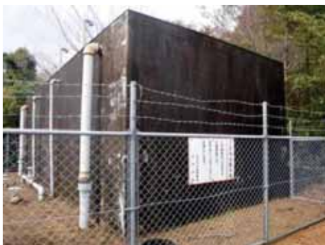
日向台配水池
