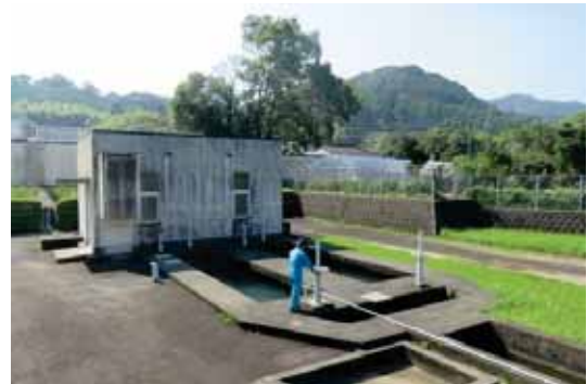
写真 3.3.3 権現原浄水場着水井
