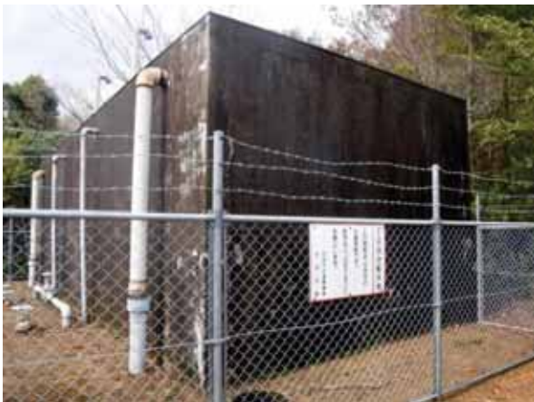
写真 4.2.1 日向台配水池
