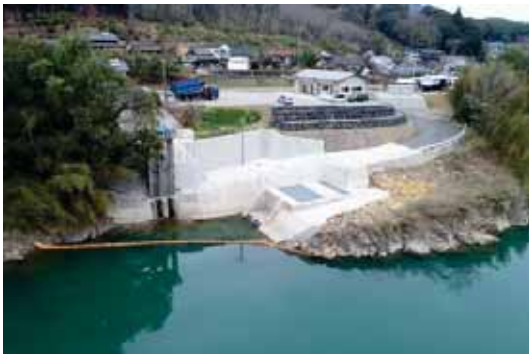
写真 3.3.2 中の原取水口
