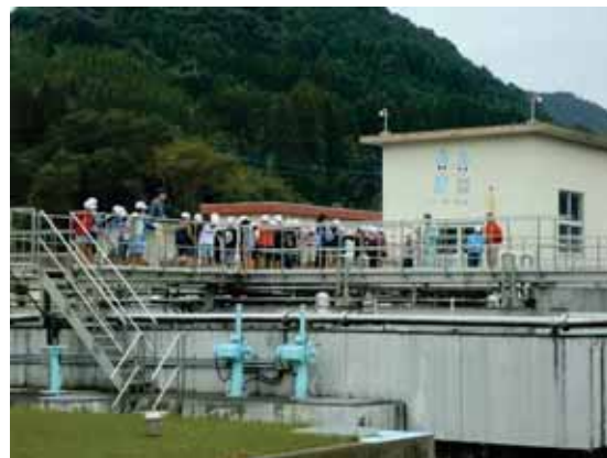
写真 6.2.3 浄水場見学の様子
