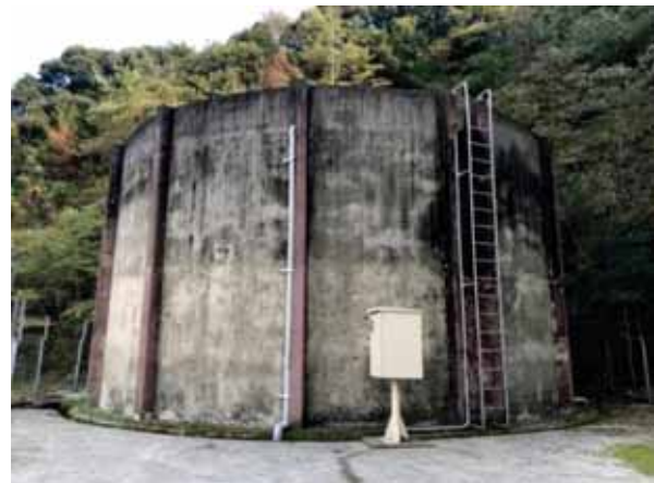
写真 4.2.2 向洋台配水池
