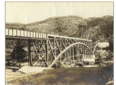
現場架設の風景
