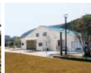
▲循環型浄化層を使用した施設（お倉ヶ浜海水浴場）
