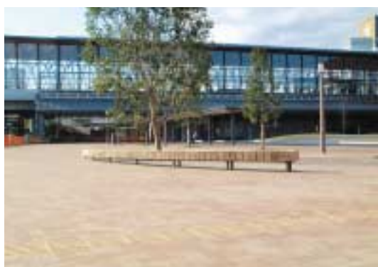
▲周辺環境に調和した施設(日向市駅)
