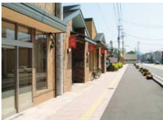
▲壁面を後退し、歩行空間の充実と賑わい空間を創出している。（駅周辺地区）
