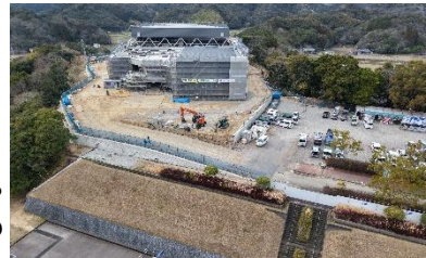
【現在、建設中の総合体育館：R8.3月時点】
