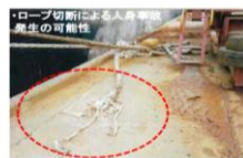
係留ロープの切断
