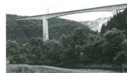
上水道大河平配水系整備が実施されるくるそん大橋
