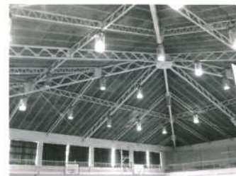
天井修繕を行う飯野中体育館
