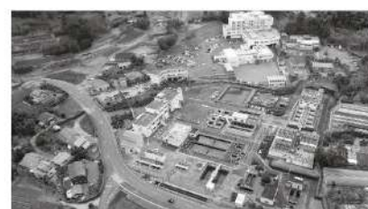
▲日向市権現原浄水場全景
