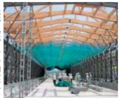
新日向市駅舎の大屋根 (建設水道委員会現地視察)
