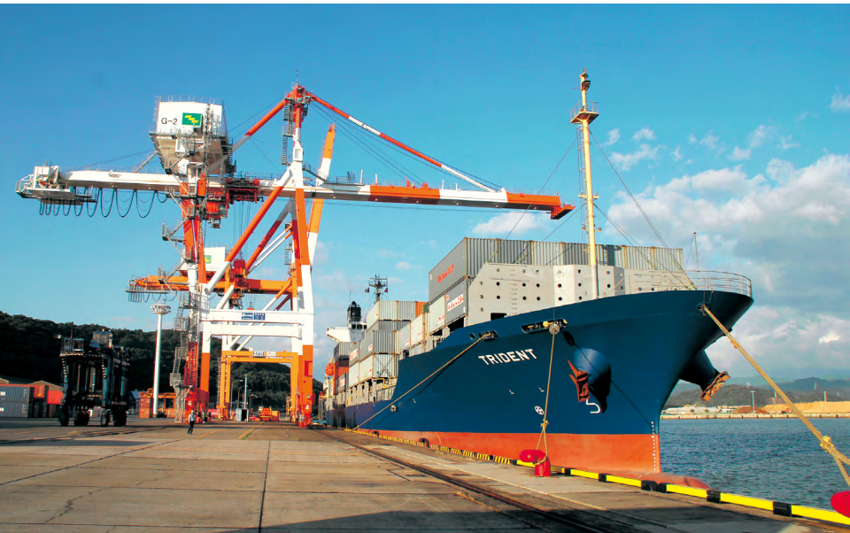
細島港コンテナターミナル
