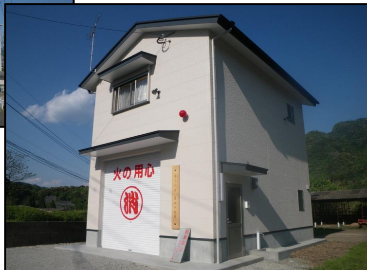
第10分団44部消防機庫
