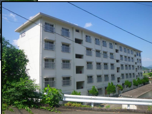
櫛の山住宅ストック総合改善(9号棟)
