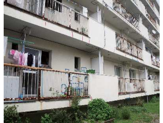
□鉄筋コンクリートの老朽化(左) □手摺の老朽化(上)
