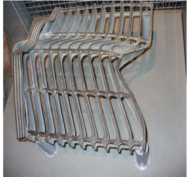
右 → 地震で変形したグレーチング
