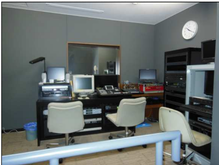
映像配信システムなどの機械室
