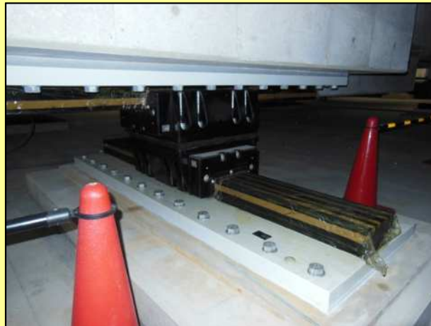
レール式転がり支承 (地下設置)
