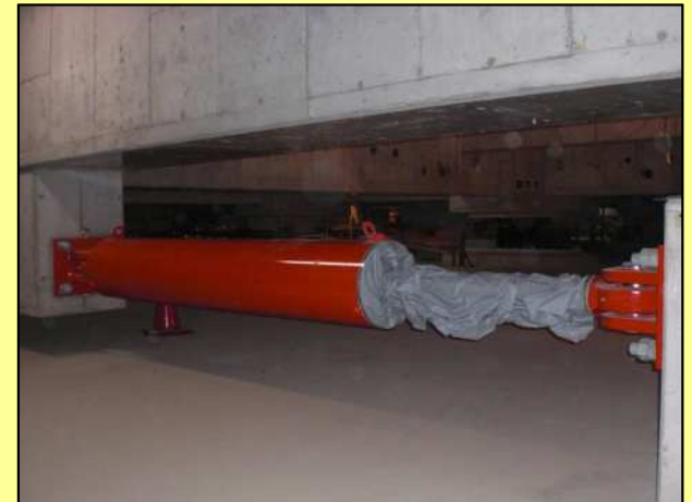
オイルダンパー (地下設置)
