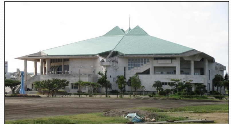
( 市立体育館[外観] : 宜野湾市 )
