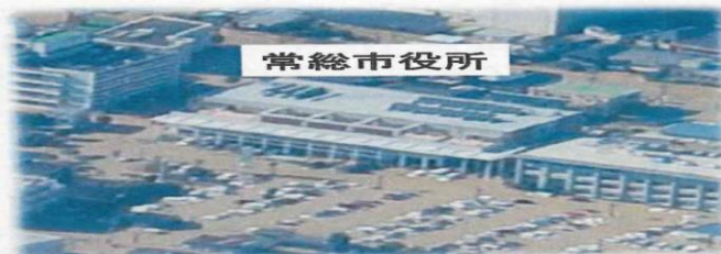
庁舎非常用電源設備 ↓
