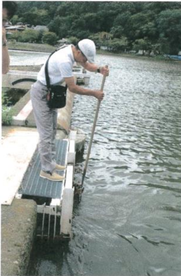
スクリーン部の清掃作業状況 日頃のメンテナンスは 保勝会のメンバーが行っている。
