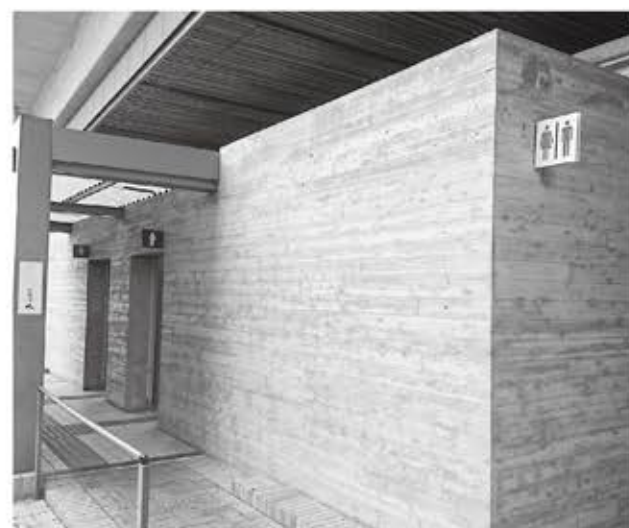
▲日向市駅高架下トイレ
