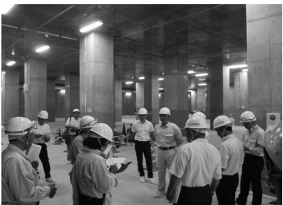
完成した地下式の保管施設
